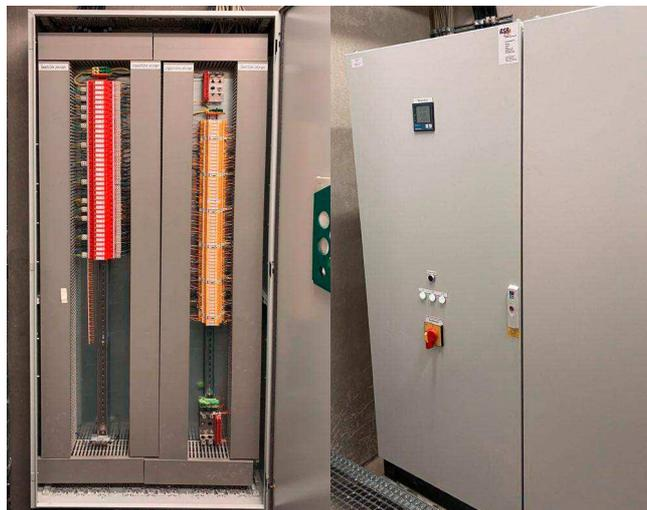
Bild 6: Anlagenschutz durch Überspannungsschutzgeräte (links Überspannungsschutz, rechts MSR-Anlage) (Quelle: Dehn SE)
