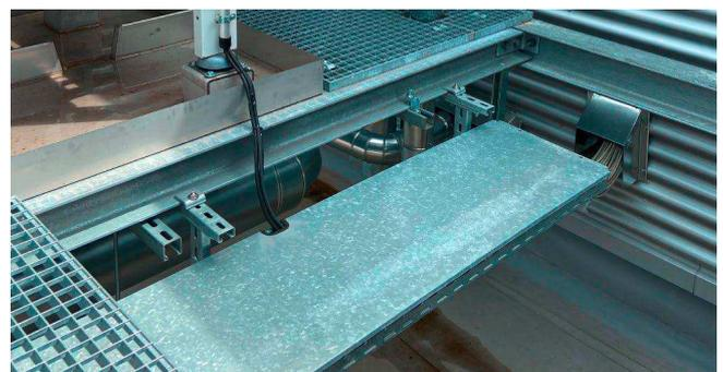
Bild 10: Anlagenschutz durch metallenen Kabelkanal
