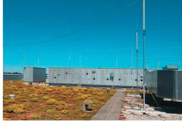
Bild 1: Getrennter Blitzschutz für gebäudetechnische Anlage
