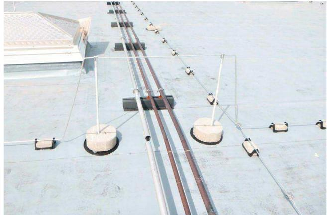
Bild 12: Trennung (durch Abstand) von gebäudetechnischen und Blitzschutz-Leitungen (Quelle: Klaus Neumann GmbH)
